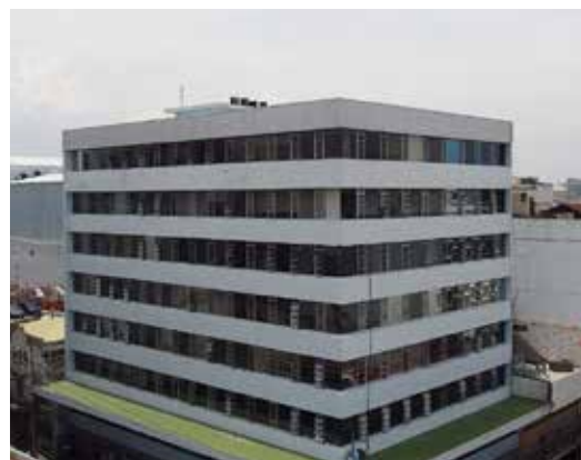
Edificio de la Oficina Nacional del Servicio Civil -ONSEC-, ubicado en 13 Calle 6-77 Zona 1, Ciudad de Guatemala.
