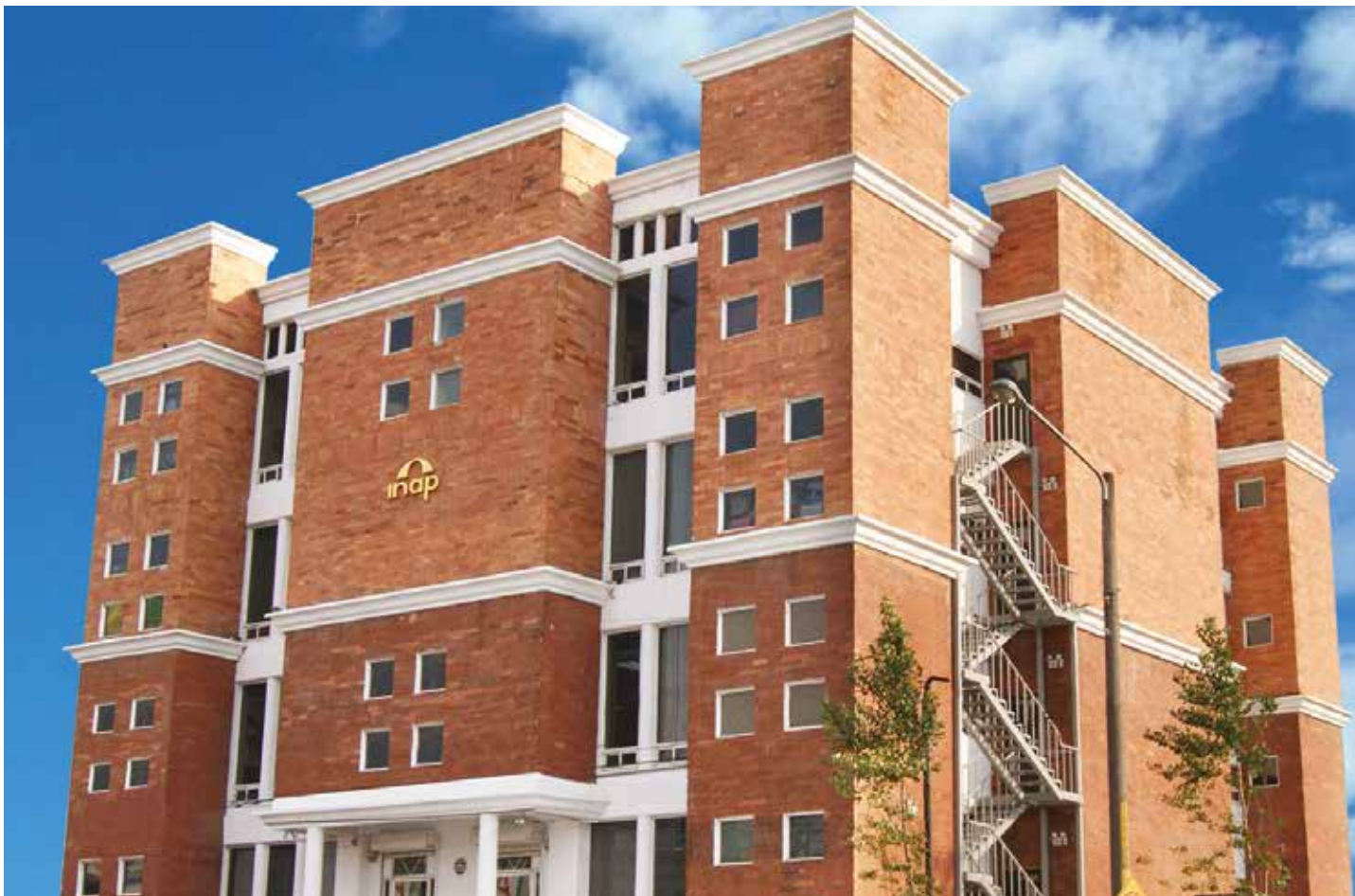
Edificio del Instituto Nacional de Administración Pública -INAP-, ubicado en Boulevard Los Próceres 16-40 Zona 10, Ciudad de Guatemala
