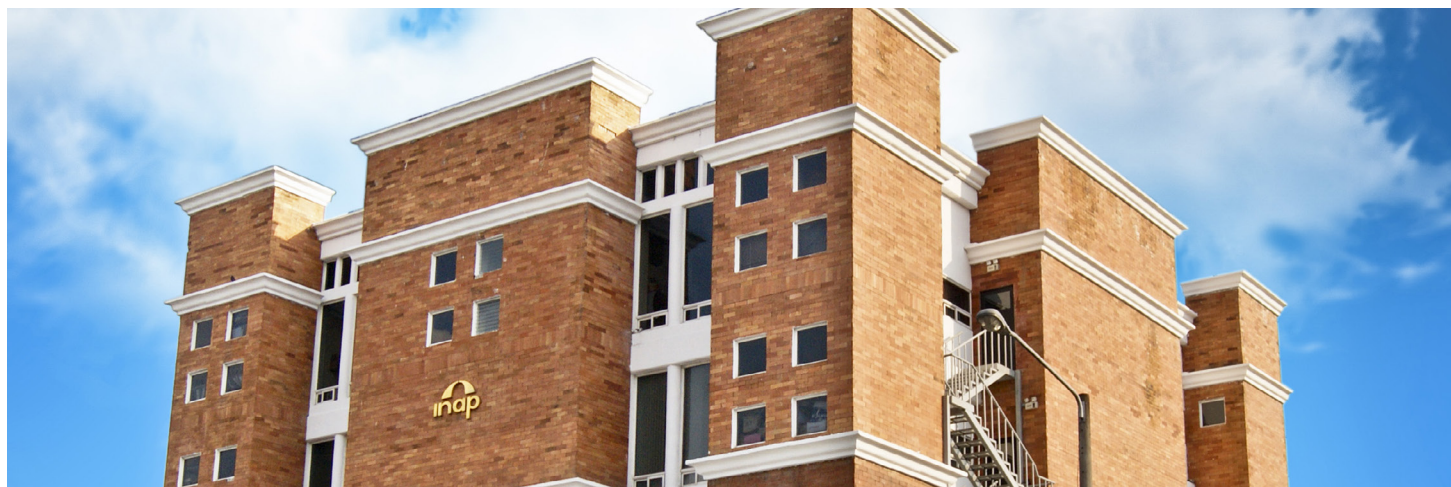
Instituto Nacional de Administración Pública -INAP- (Foto INAP 2013).
