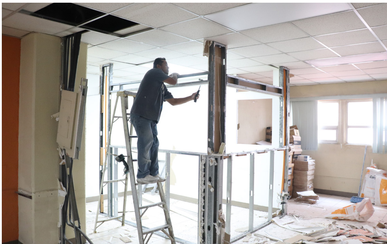
Reestructura y remodelación de espacios.
